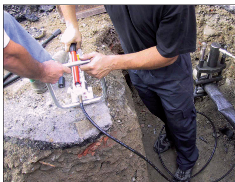
Operazione di pompaggio per lo schiacciamento del tubo
