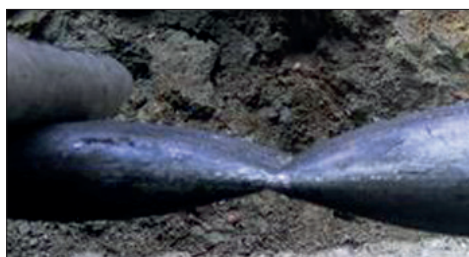
Cilindro e staffa possono essere staccati e lasciare il morsetto in posizione di schiacciamento per ripetere la stessa operazione in un altro punto del tubo con un altro morsetto.
