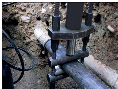
Cilindro e staffa possono essere staccati e lasciare il morsetto in posizione di schiacciamento per ripetere la stessa operazione in un altro punto del tubo con un altro morsetto.
